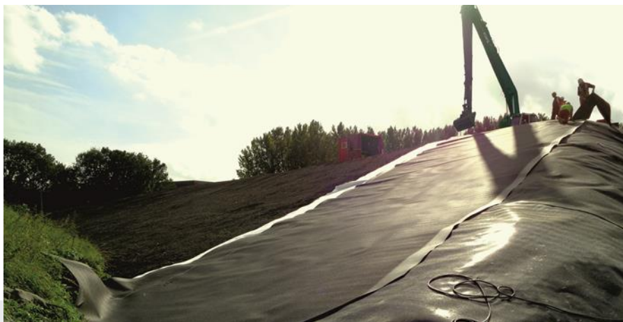
Foto: overzicht aanleggen IBC werk.
